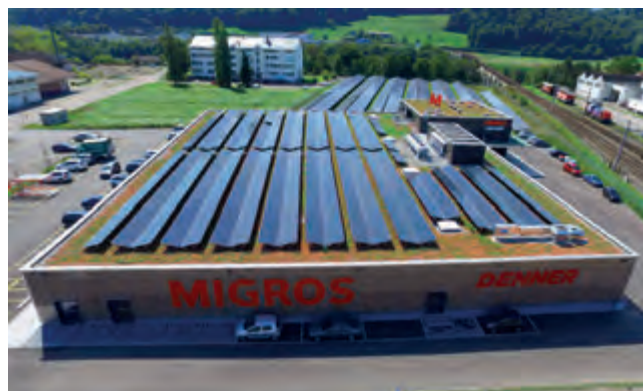
Migros Eglisau: Neubau punktet mit viel Holz und Energie-Effizienz.
