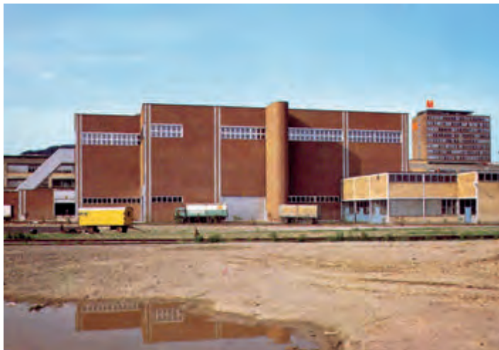
Oben: Eine Aufnahme aus dem Jahre 1980 nach abgeschlossenen Bauarbeiten
